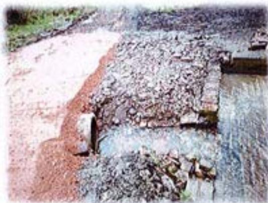
Une partie de la voûte passant sous le chemin étant en mauvais état, celle-ci a été remplacée par une buse.
